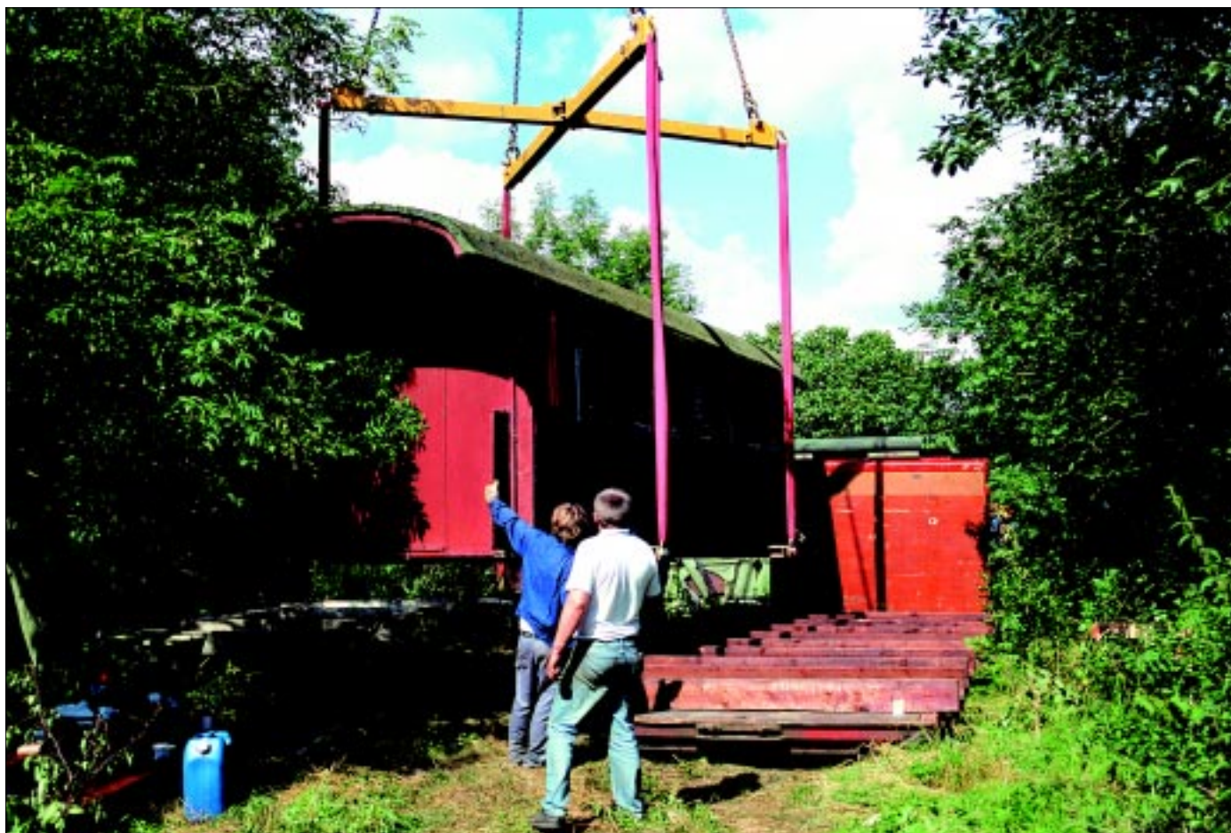
Den mest kritiske del af operationen: En vognkasse er netop løftet fra fundamentet til venstre og er nu på vej mod det omdannede veksellad i højre side af billedet
