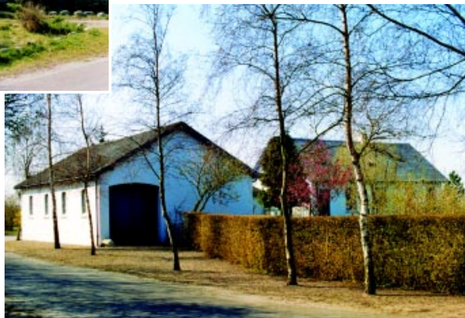
Guldbjerg station med rejsestalden til venstre.
