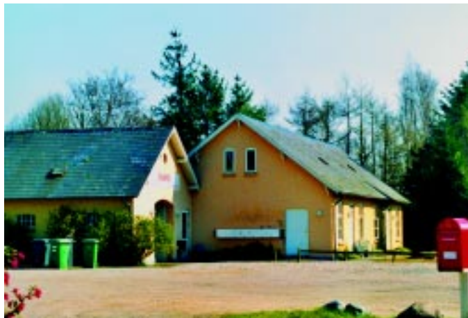
Skamby station. Antallet af ungdomslejligheder fremgår af rækken af postkasser på gavlen.
