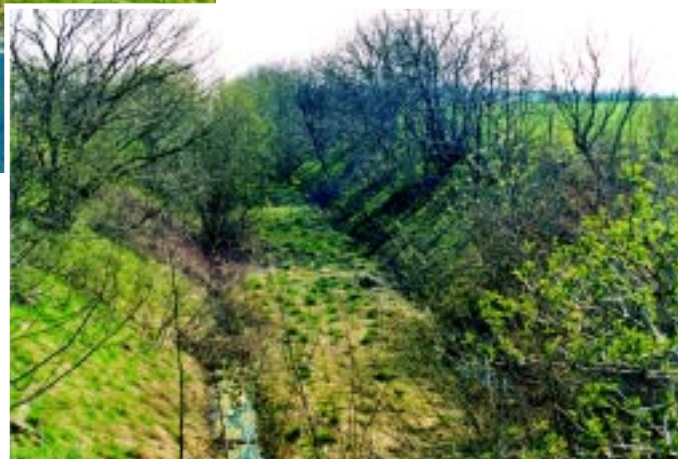
Gennemskæring ved den tidligere bro syd for Rostrup
