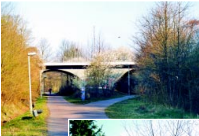
Viadukten for Stadionvej i Odense. Hertil fulgtes OMB og NFJ ad, hvorefter NFJ drejede mod nord til højre.
